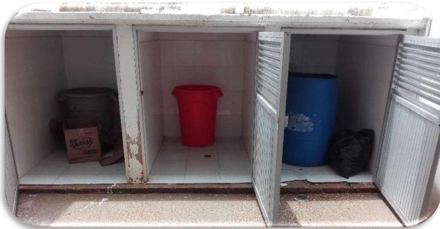
**No conformidad N°3 / Observación N°3:** Se evidencia mal estado de los almacenamientos temporales que se encuentran ubicados en diferentes puntos dentro en la entidad, tienen puertas averiadas, cierres oxidados, algunos sin señalización.
