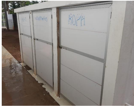
Imagen N° 35. Almacenamiento Temporal Aislamiento COVID-19
