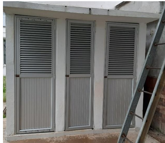
Imagen N° 37. Almacenamiento Temporal UCI
