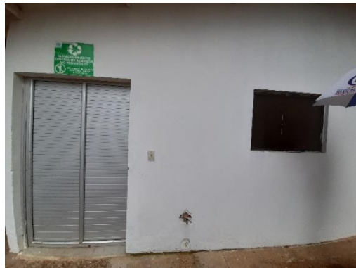
Imagen N° 38. Almacenamiento Central No Peligroso Externo
